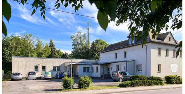
Das ehemalige Kindergartengebäude. Foto: Thomas Puschmann
