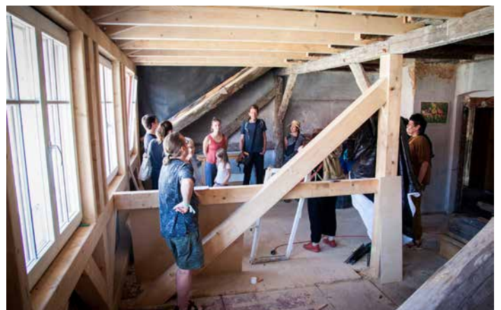
Dachausbau eines Hausprojektes in Görlitz. Foto: Diana Neumerkel
